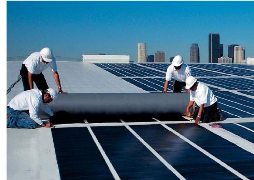
☞ Photographie 1 : Mise en place de membrane photovoltaïque (Source : Solaris energy)
