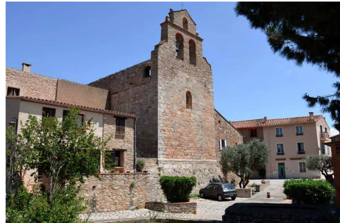
Photographies : Vue de l'église paroissiale de Sainte-Colombe-de-la-Commanderie
