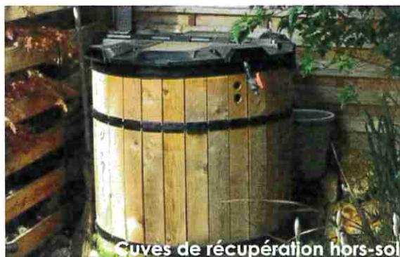
Cuves de récupération hors-sol
