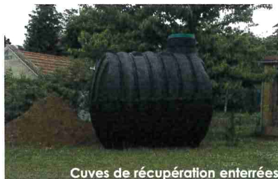
Cuves de récupération enterrées
