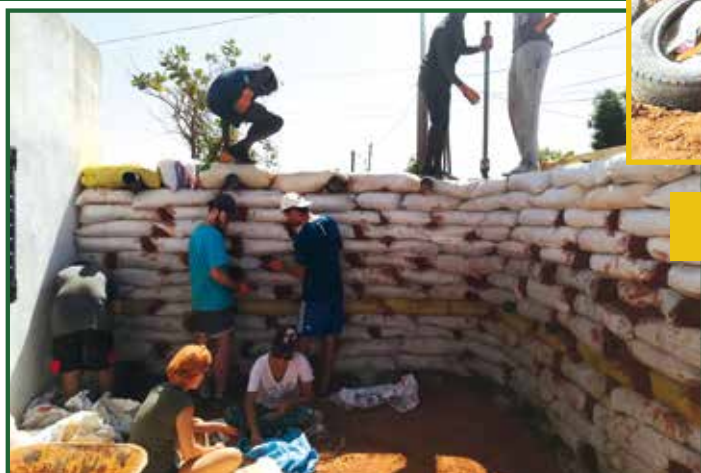
Pose des joints sur le chantier
