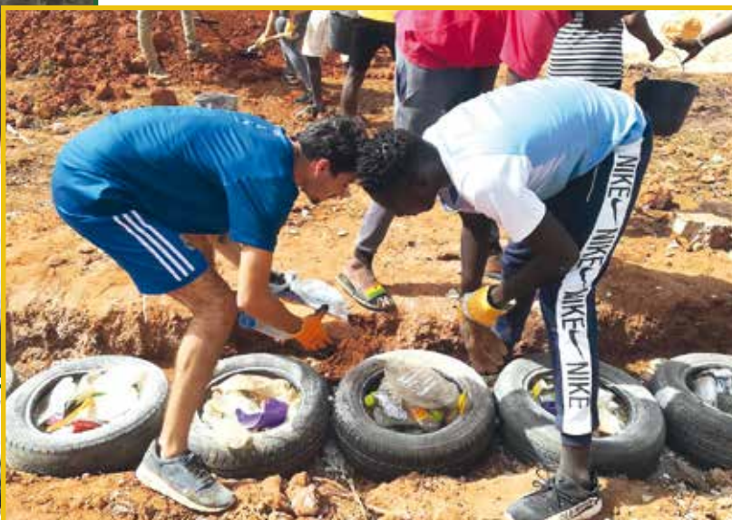
Recyclage : Pneus remplis de déchets plastique pour les fondations
